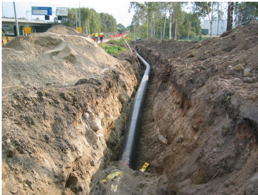
Figur 4-1 Förläggning av gasrör genom schaktning
